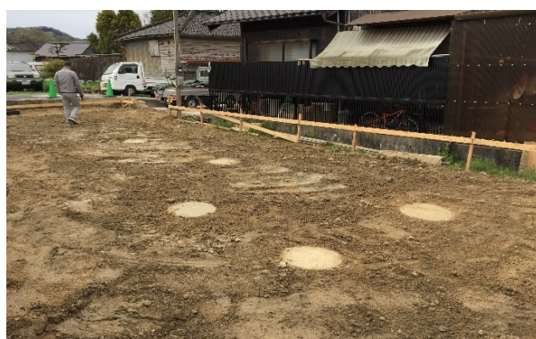
柱状改良施工後の写真
